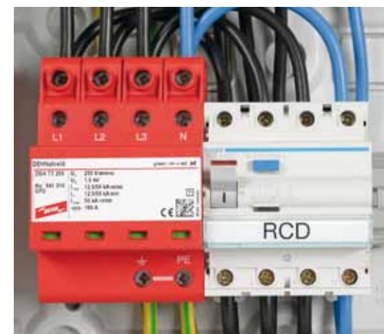
Obr. 2 DEHNshield, vnitřně propojený a aplikačně optimalizovaný kombinovaný svodič na bázi jiskřiště [1]
