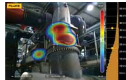
Barevná mapa zobrazující vibraci potrubí
