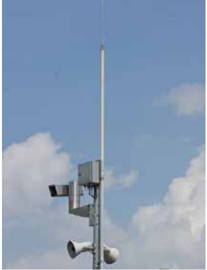
Izolovaný LPS za pomoci vodiče HVI
