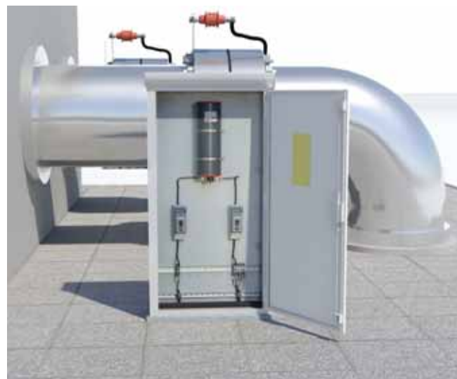
Obrázek 6 Kombinace oddělovacího jiskřiště a omezovače
